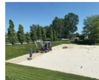
Frühjahrsarbeiten am Badeteich waren im Vorjahr umfangreich.
