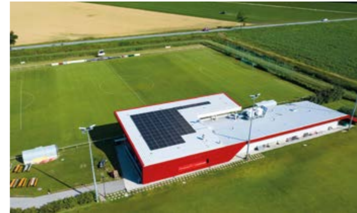
Neue PV-Anlage auf dem Dach des Fußballvereins mit ca. 30 kWp.
