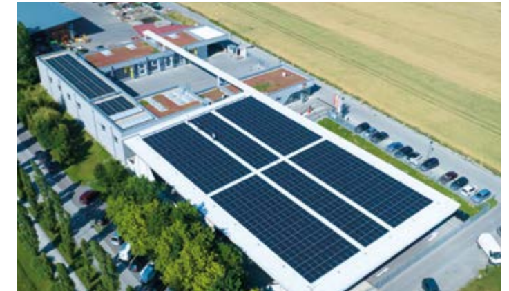
Neue PV-Anlage auf dem Abfallsammelzentrum mit ca. 280 kWp.
